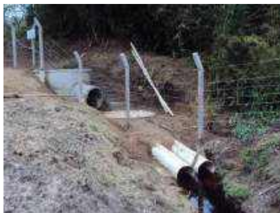
Figura 2.5.4-10: Melhorias na saída da manilha final de efluentes
