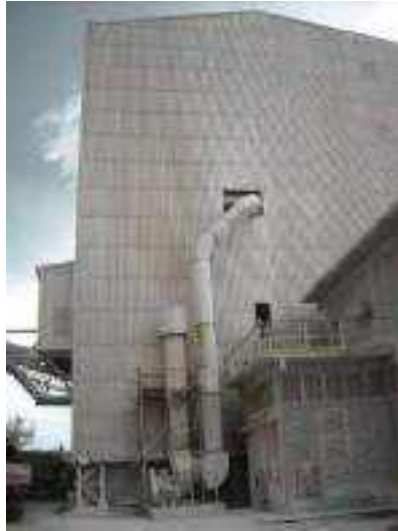
Figura 3.22: Vista geral da chaminé do sistema de despoeiramento da granulação
