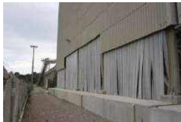
Figura 2.2.5.2-29: Vista do prédio da moagem após a instalação das cortinas plásticas protetoras
