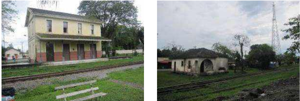
Figura 4.3.5.2-1. Estação Ferroviária e estruturas relacionadas, no município de Alexandra.
