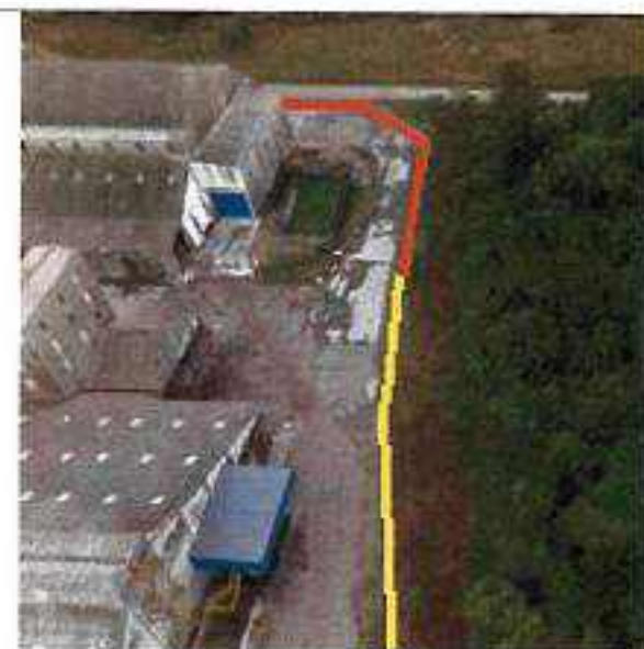
Figura-10 Canaleta de Extravasão, continuação, lado leste, com necessidade de obra (linha amarela) e obra finalizada (linha vermelha).
