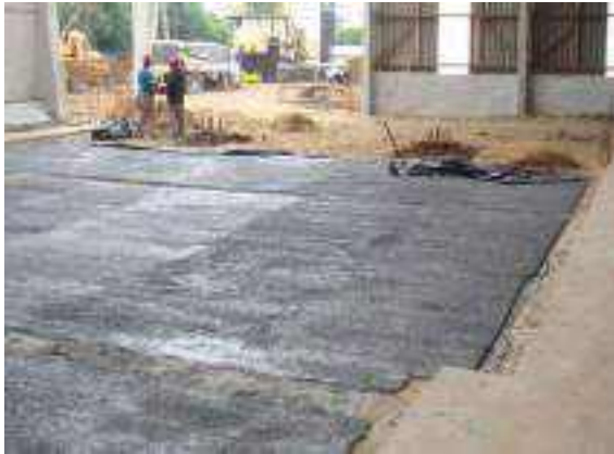
Figura 2.2.4.2-11: Implantação piso impermeabilizado na área dos armazéns de estocagem de fertilizantes (mai/2008).
