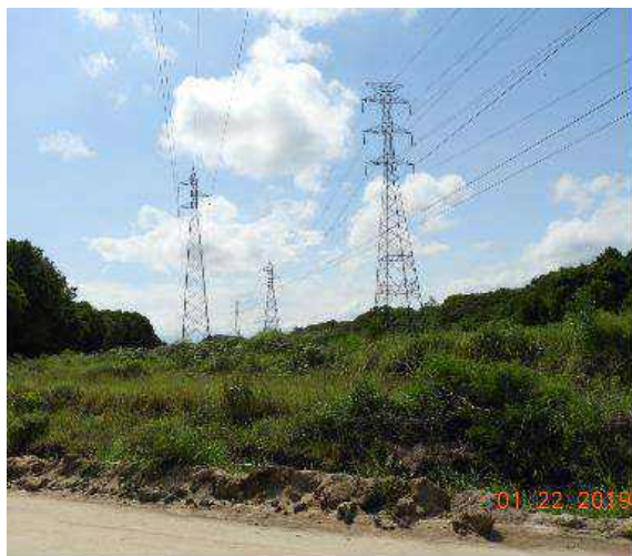
Figura 4.2.1.3.9-9: Vegetação antropizada (campo antrópico) se desenvolvendo sob Linha de Transmissão, na região oeste da AID.
