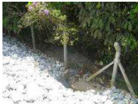
Figura 2.2.4.2-6: Vista da construção das redes de drenagem definitivas (jan/2008).
