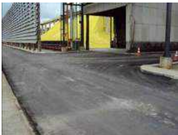
Figura 2.2.5.2-1: Vista das áreas de acesso à descarga de enxofre pavimentada (antes da instalação de cortinas)
