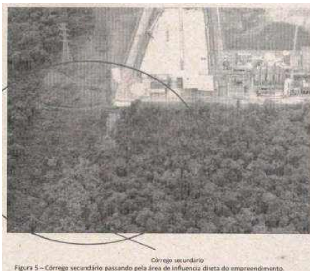
Figura 56 – Pg. 2833 dos Autos - Indicação do MPE da existência de córrego secundário.
