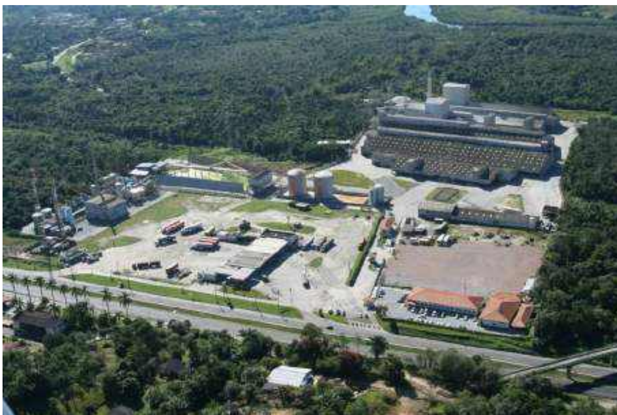
Figura 2.3.1-1: Vista da área da unidade da Fertilizantes Heringer de Paranaguá-PR.
