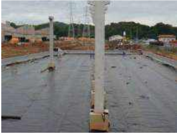
Figura 2.2.4.2-7: Vista da implantação de pátio de estocagem de enxofre. Impermeabilização com PEAD – Polietileno de Alta Densidade (abr/2008).
