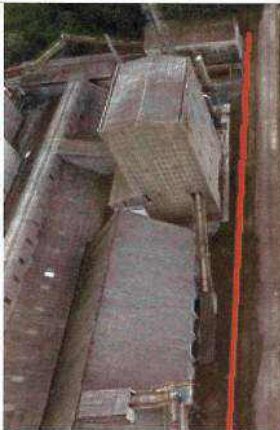
Figura-12 Canaleta de Extravasão, continuação, lado norte, obra finalizada (linha vermelha).
