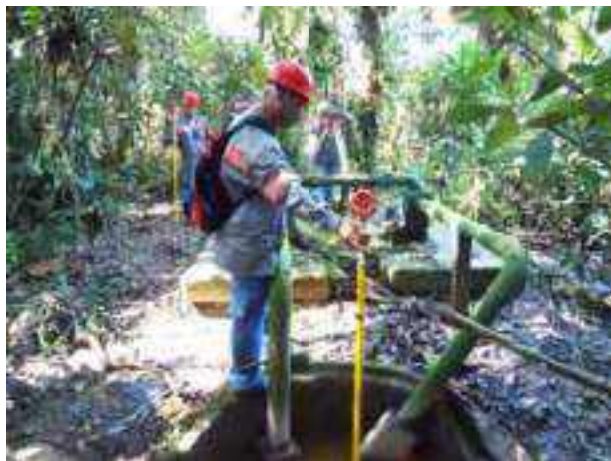
Figura 20 - Levantamento com estação total do centro do poço de captação.
