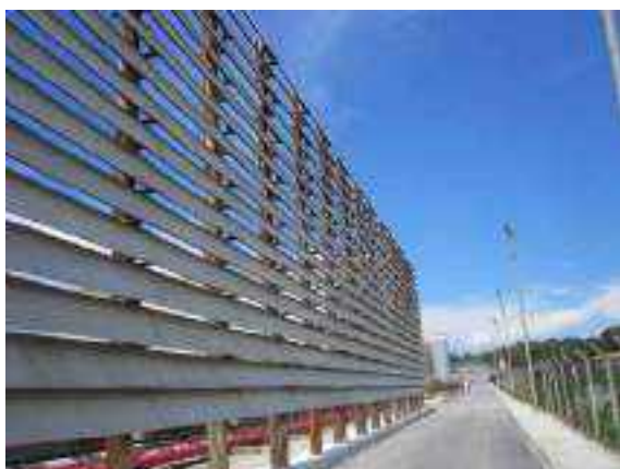
Figura 2.2.5.2-3: Instalação de venezianas para controle de poeiras (barreiras contra vento) e diminuição do impacto visual das pilhas.
