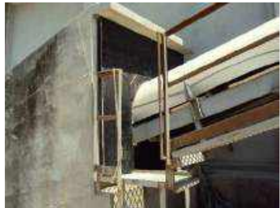
Figura 2.2.5.2-18: Vista do detalhe do fechamento realizado no ponto de transferência das correias interna/externa
