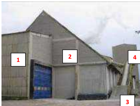
Figura 2.2.3.2-3: Vista geral das áreas de recebimento (1), estocagem (2), transporte de rocha (3) e moagem (4)
