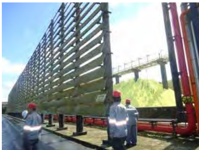
Figura 72 - Venezas instaladas no pátio de armazenamento de enxofre
