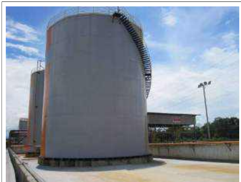
Figura 2.12: Detalhe do dique de contenção dos tanques de armazenamento de ácido sulfúrico
