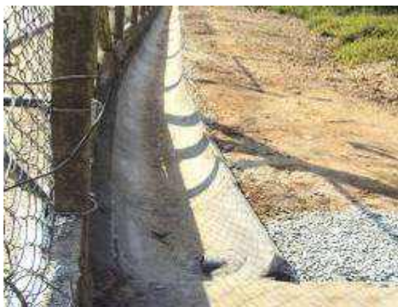
Figura 2.5.4-3: Obras de drenagem para segregação das águas pluviais provenientes de área contígua ao site da empresa
