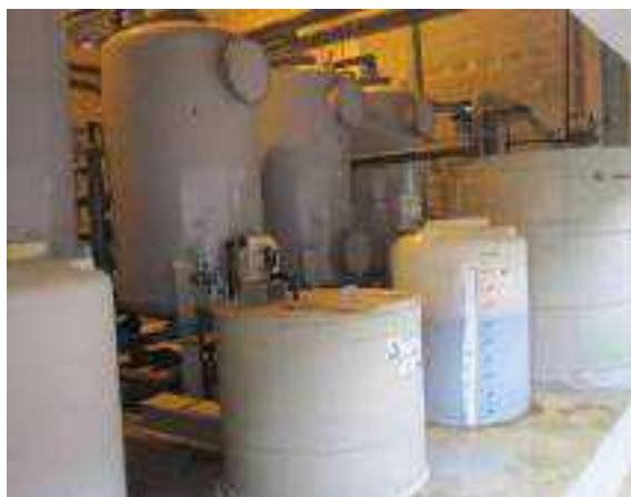
Figura 2.2.3.1-12: Vista geral da ETA
