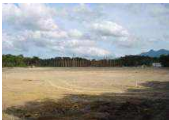
Figura 2.2.4.1-7: Início das obras de implantação dos armazéns das Misturas (2005).
