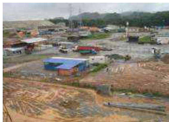
Figura 2.2.4.1-10: Canteiros de obras e unidade misturadora em operação (fev/2008).
