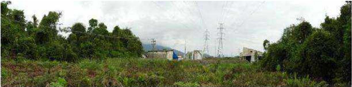
Figura 4.2.1.3.9-13: Vista de um trecho com vegetação pioneira na faixa de domínio da Linha de Transmissão.
