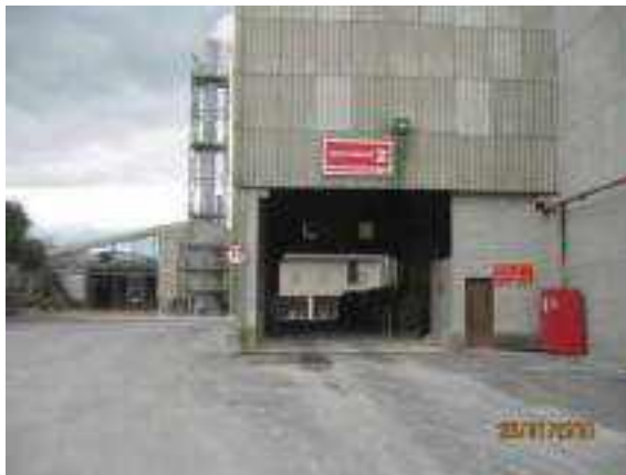
Figura 2.2.3.4-1: Vista do detalhe da área de descarregamento da Mistura 2
