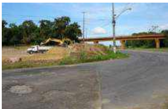
Figura 2.2.4.1-5: Vista geral da terraplanagem da área para implantação das áreas administrativas (jan/05).
