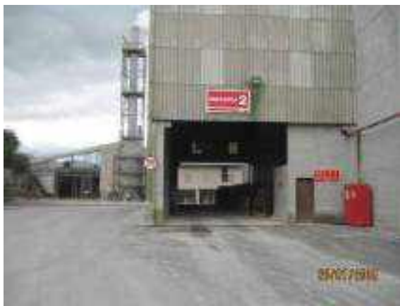
Figura 2.23: Detalhe da área de descarregamento 2
