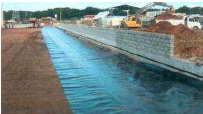
Figura 65 - Colocação da geomembrana sobre a areia.
