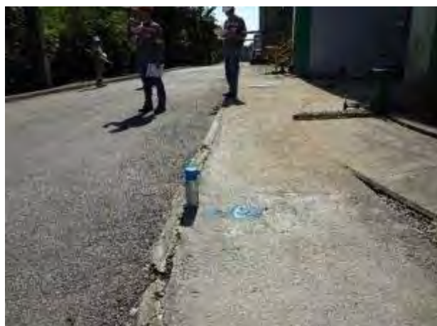
Figura 55 – Vista das construções junto ao limite da APP
