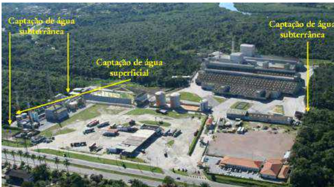
Figura 3.27: Locais de captação de água no CIP
