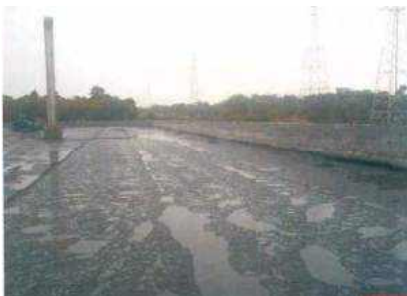
Figura 69- Imprimação asfáltica.
