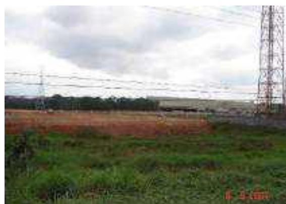
Figura 2.2.4.1-8: Obras de preparação do terreno para a implantação das unidades industriais (set/2007).
