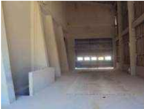
Figura 2.2.5.2-15: Vista do galpão e moega de recebimento de rocha. Ao fundo porta de contenção de poeiras fechada
