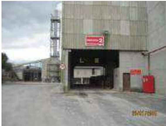
Figura 3.23: Detalhe da área de descarregamento 2
