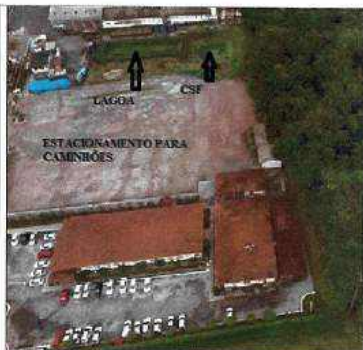
Figura-07 Obra da Lagoa e da CSF (escavações terminadas e obra paralisada).
