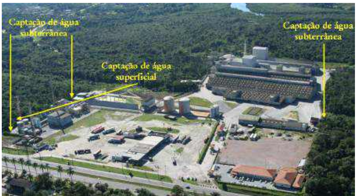
Figura 2.27: Locais de captação de água no CIP
