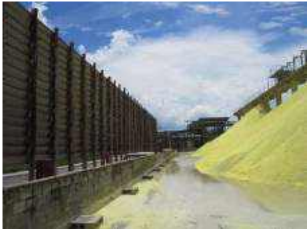
Figura 2.5: Detalhe da barreira com venezianas do pátio de estocagem de enxofre
