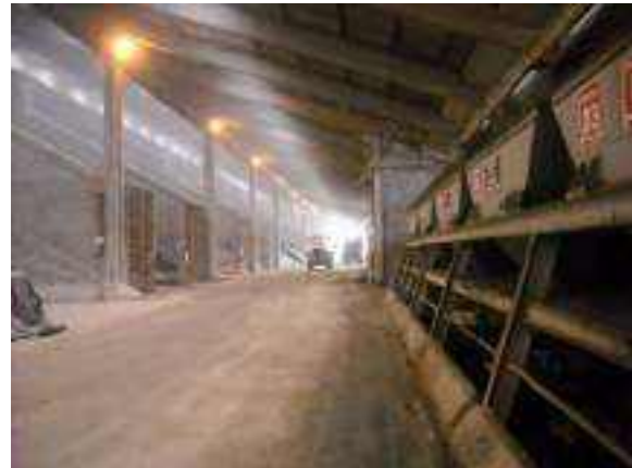
Figura 3.24: Área interna do armazém das Misturas 3 e 4
