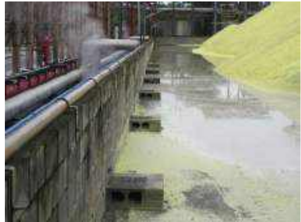
Figura 2.6: Sistema de contenção utilizando caixa com brita do pátio de estocagem de enxofre.
