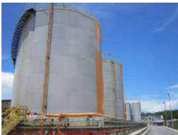
Figura 2.10: Tanques de armazenamento de ácido sulfúrico
