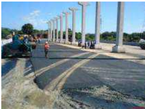
Figura 2.2.4.2-9: Implantação de pátio de estocagem de enxofre. Aplicação de asfalto (abr/2008).
