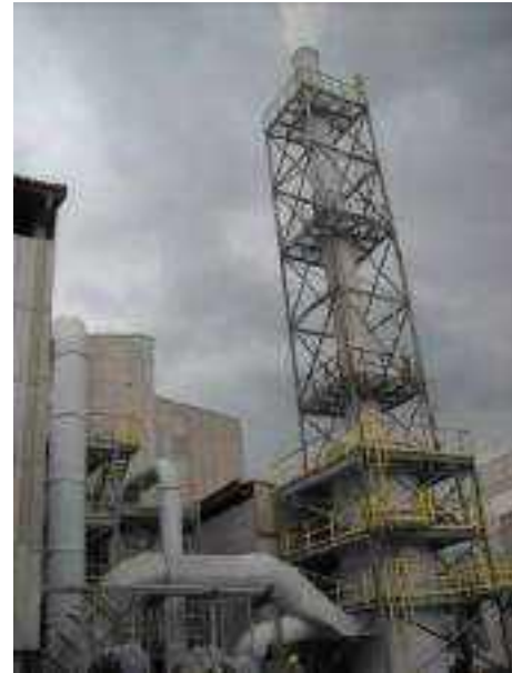
Figura 2.2.5.2-36: Vista do último estágio de lavagem de gases da Granulação e chaminé
