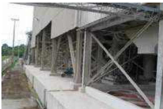
Figura 2.2.5.2-28: Vista do prédio da moagem antes da instalação das cortinas plásticas protetoras
