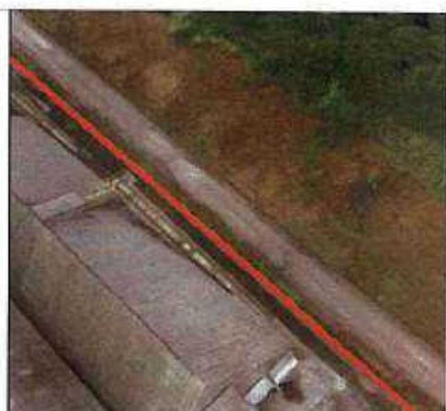
Figura-11 Canaleta de Extravasão, continuação, lado norte, obra finalizada (linha vermelha).
