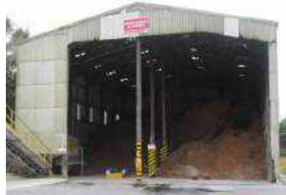
Figura 2.2.3.3-6: Vista do armazém do cavaco para abastecimento da caldeira de biomassa
