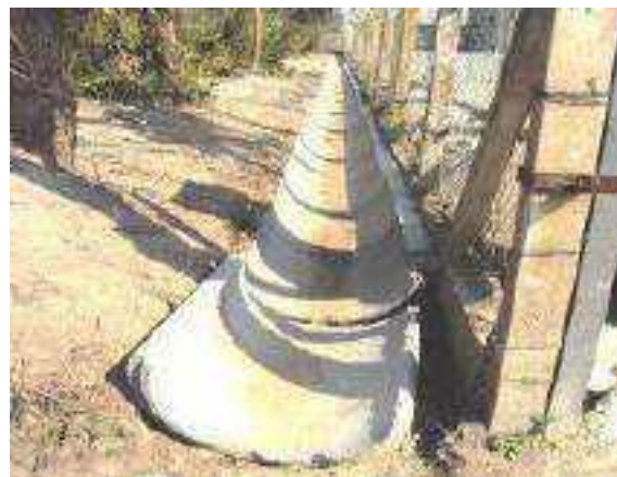
Figura 2.5.4-4: Obras de drenagem para segregação das águas pluviais provenientes de área contígua ao site da empresa
