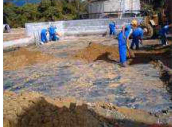
Figura 2.2.4.2-8: Vista de implantação de pátio de estocagem de enxofre. Aplicação de camada de argila sobre a manta de PEAD – Polietileno de Alta Densidade (abr/2008).
