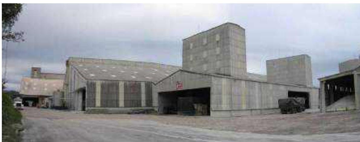
Figura 2.2.3.5-5: Vista de parte dos pátios e vias internas do empreendimento (Lateral esquerda)
