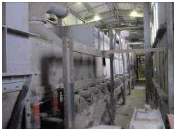
Figura 2.2.3.2-9: Vista geral da área da correia de reação e DEN (enclausuramento)
