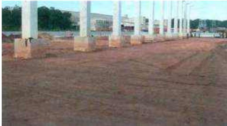
Figura 64 - Terreno compactado sendo preparado para colocação da camada de areia.
