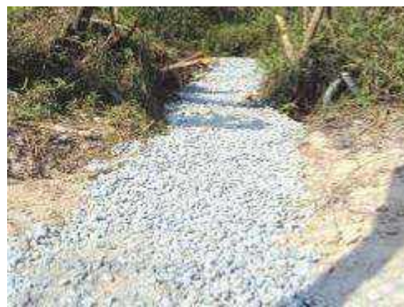
Figura 2.5.4-6: Obras de drenagem para segregação das águas pluviais provenientes de área contígua ao site da empresa
