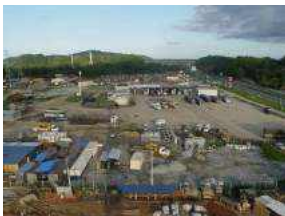
Figura 2.2.4.2-1: Vista da organização dos materiais nos canteiros de obras (mar/2008).
