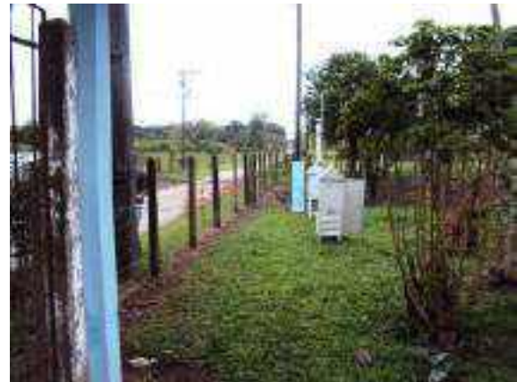
Figura 4.1.2.4-5: Vista de equipamentos alocados no Ponto 2
