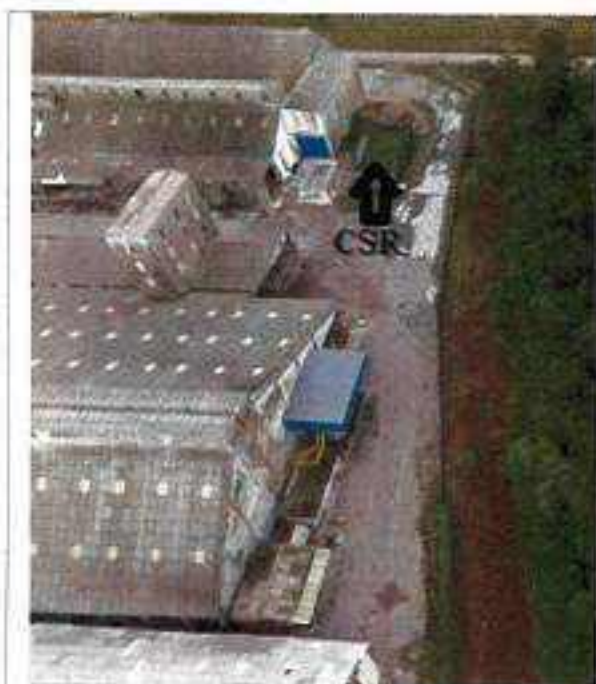
Figura-06 Obra da CSR (escavações terminadas e obra paralisada).
