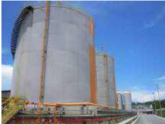
Figura 2.2.3.1-7: Vista dos tanques de armazenamento de ácido sulfúrico
