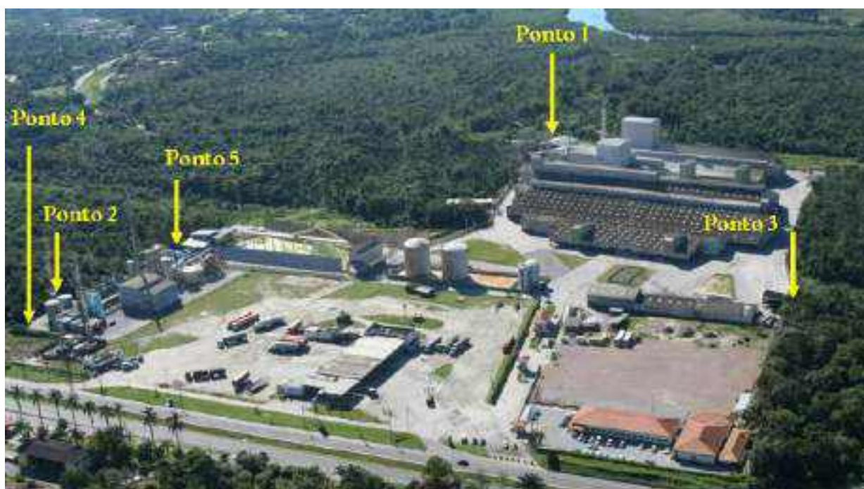
Figura 2.5.1-1: Locais de captação de água no empreendimento – Pontos 1 a 5
