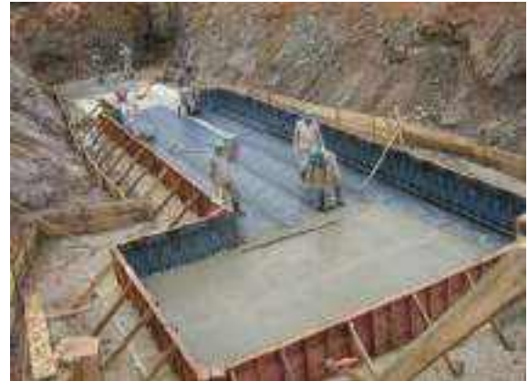
Figura 2.2.4.2-12: Impermeabilização com manta, antes da concretagem na área da moega de descarga de enxofre (fev/2008).
