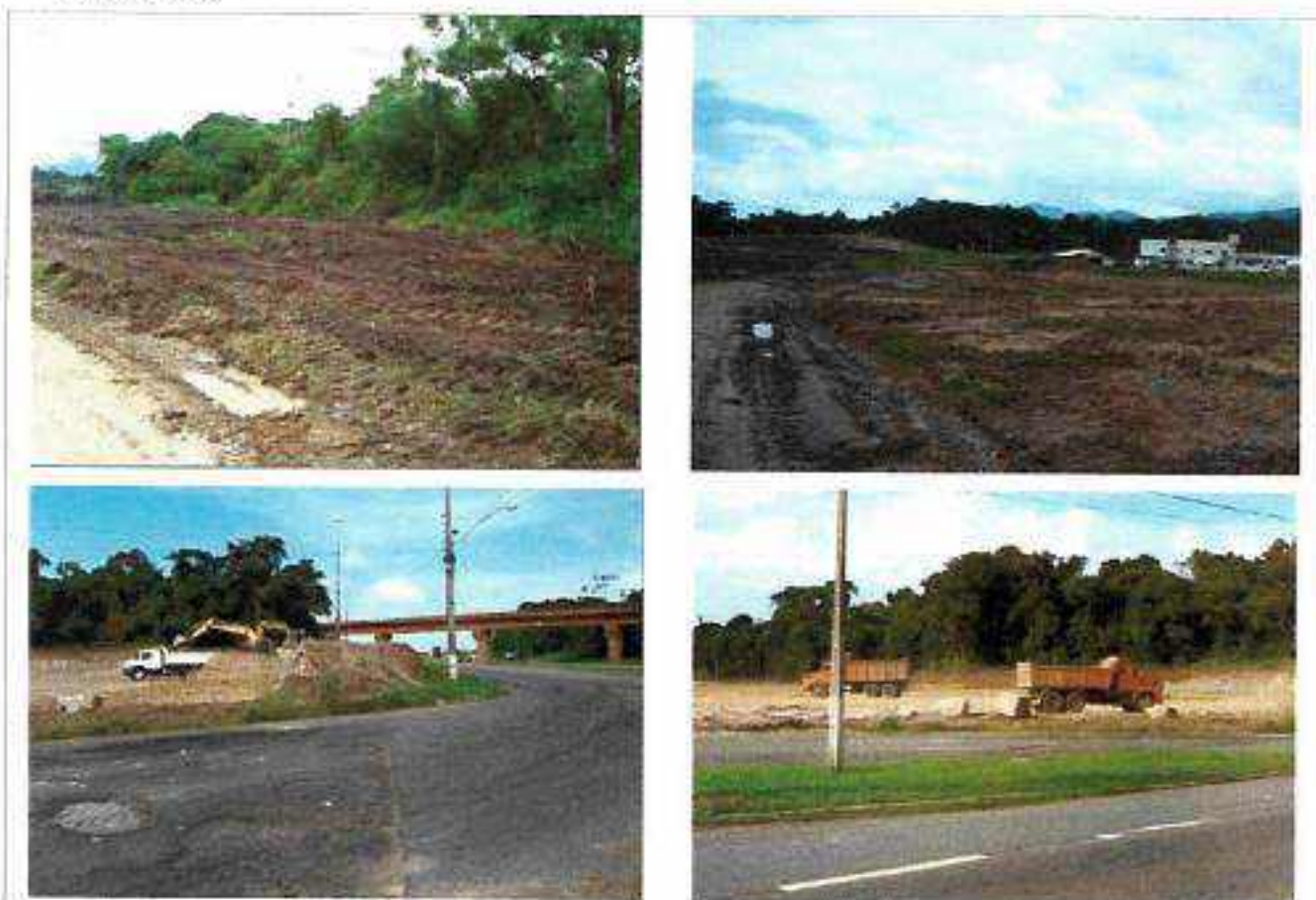
Figura-02 Fotos da etapa de terraplanagem (Jan/2005).
