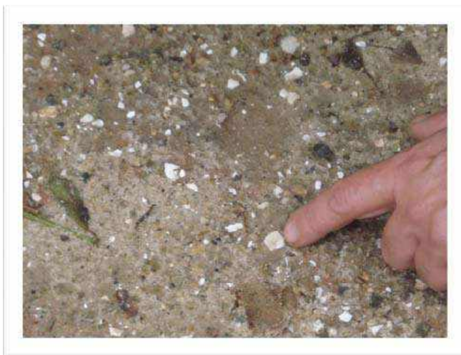
Figura 14 Detalhe de conchas fragmentadas em leito de estrada nos fundos do empreendimento
