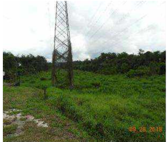
Figura 4.2.1.3.3-41: Ao fundo da imagem, dos dois lados da linha de transmissão, estão os fragmentos de Floresta Ombrófila Densa de Terras Baixas em estágio avançado de regeneração da região oeste da área de estudo.
