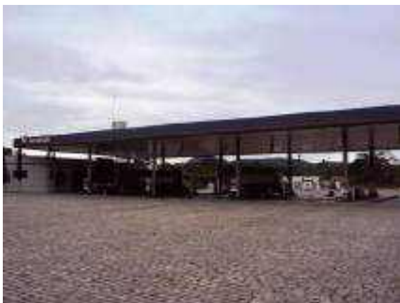
Figura 4.1.2.4-2: Vista geral do posto de combustível "Potencial" - Ponto 1
