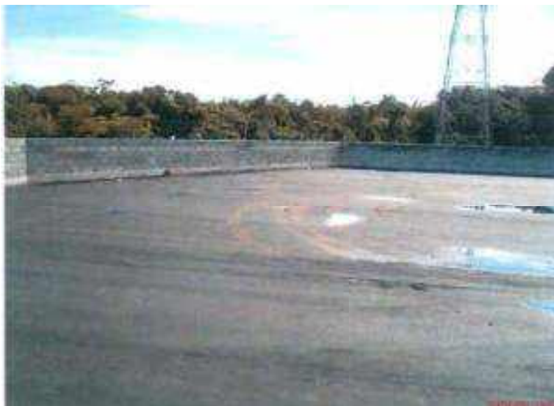
Figura 70 - Acabamento com asfalto.
