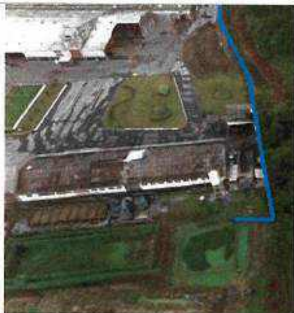
Figura-08 Canaleta de Extravasão, lado leste, com necessidade de escavação e obra (linha azul).
