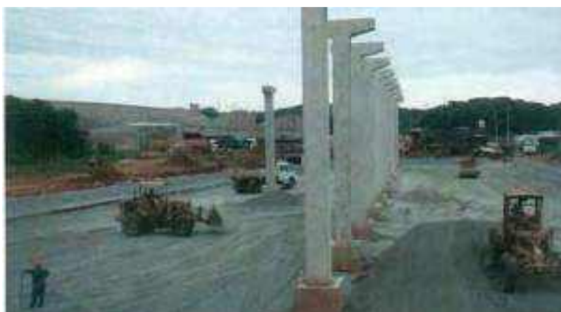
Figura 68 - Aplicação de camada de bica corrida sobre a geomembrana.
