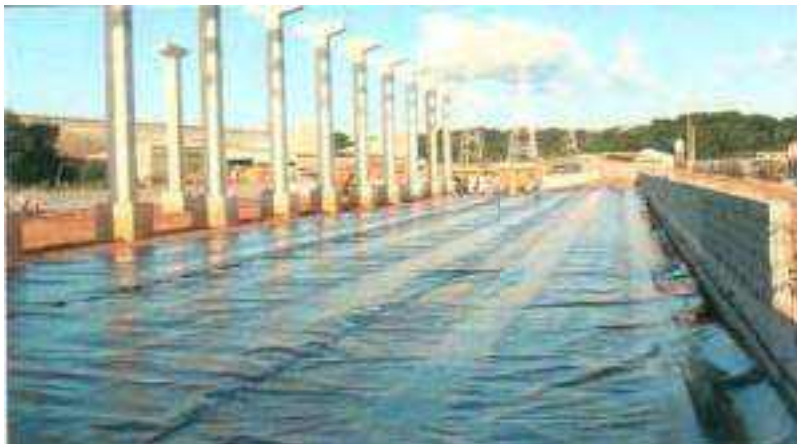
Figura 66 - Colocação da geomembrana.
