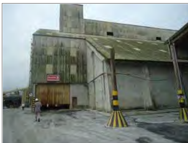
Figura 63 - Cortinas para contenção de poeiras fugitivas.
