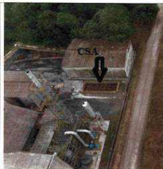
Figura-04 CSA – Instalada e operando desde 2009.
