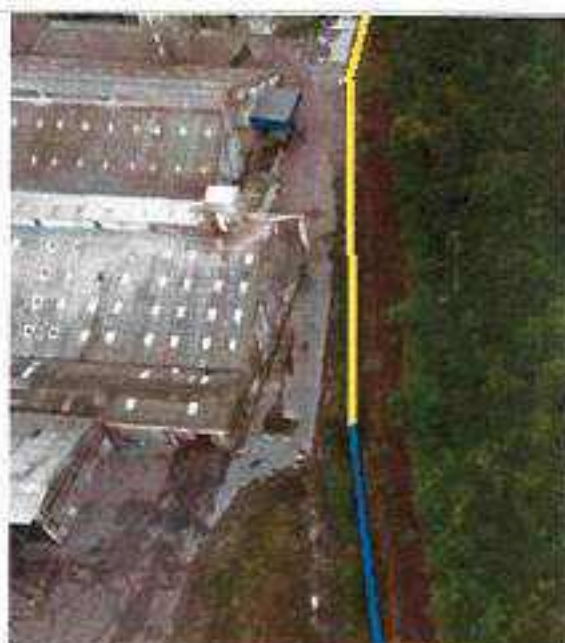
Figura-09 Canaleta de Extravasão, continuação, lado leste, com necessidade de escavação e obra (linha azul) e com necessidade de obra (linha amarela).
