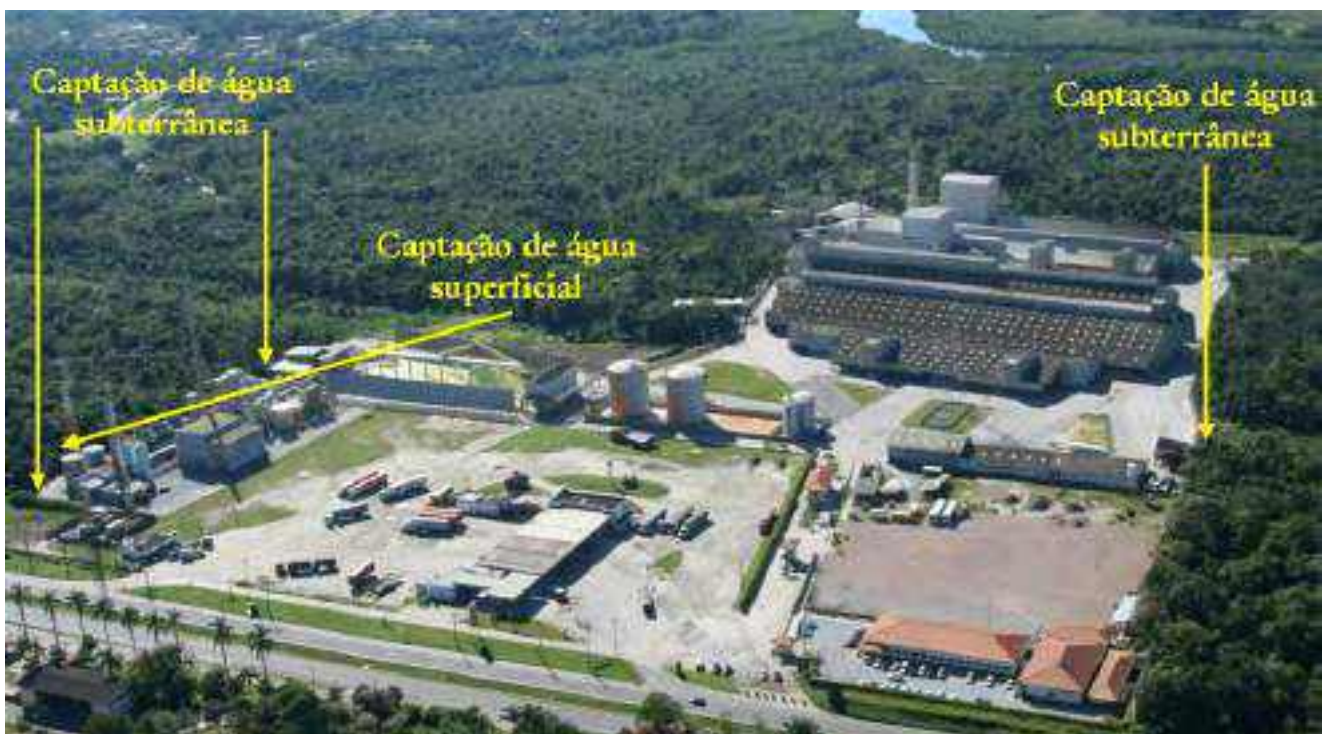
Figura 2.27: Locais de captação de água no CIP
