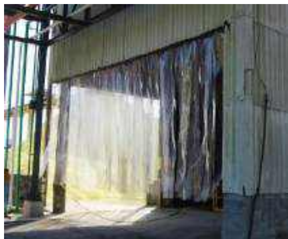
Figura 2.2.3.1-2: Área de descarregamento de enxofre com as cortinas protetoras.
