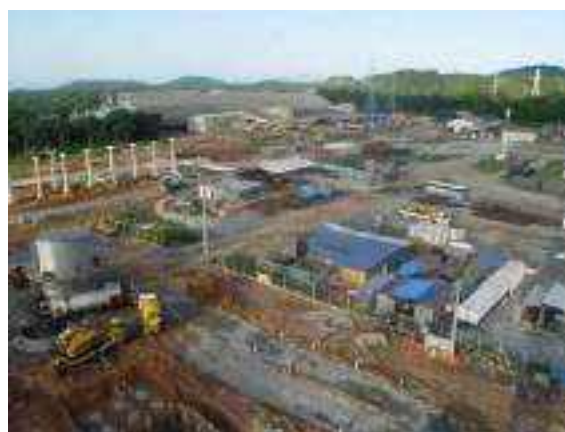
Figura 2.2.4.2-2: Vista da organização dos materiais nos canteiros de obras (mar/2008).
