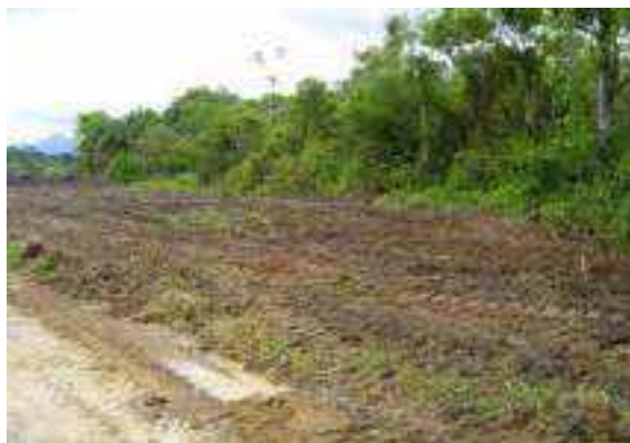
Figura 2.2.4.1-3: Vista geral da terraplanagem da área para implantação da unidade de mistura (jan/05).
