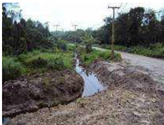
Figura 2.5.4-12: Valeta para a condução das águas descartadas até o Rio Veríssimo
