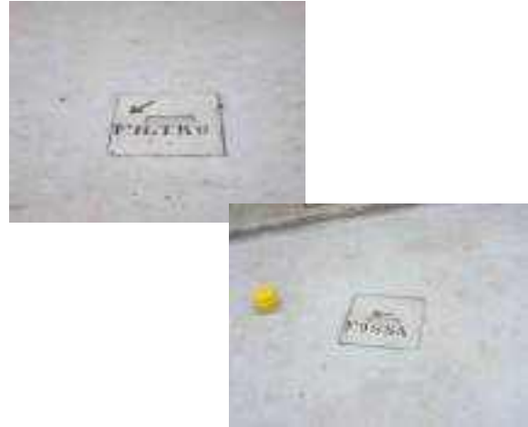
Figura 2.5.4-8: Novo sistema de fossa filtro anaeróbio (FFA), instalado no sanitário do Setor de Armazéns (SA)
