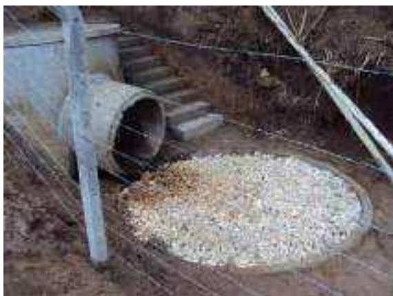
Figura 2.5.4-9: Melhorias na saída da manilha final de efluentes
