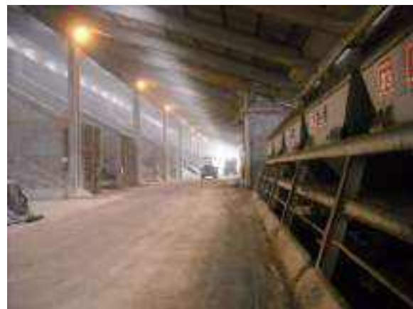
Figura 2.24: Área interna do armazém das Misturas 3 e 4
