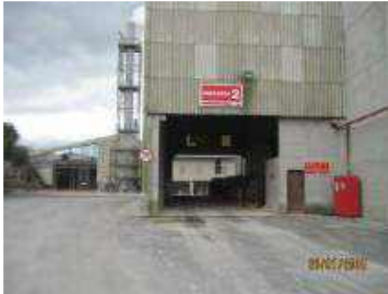
Figura 2.23: Detalhe da área de descarregamento 2
