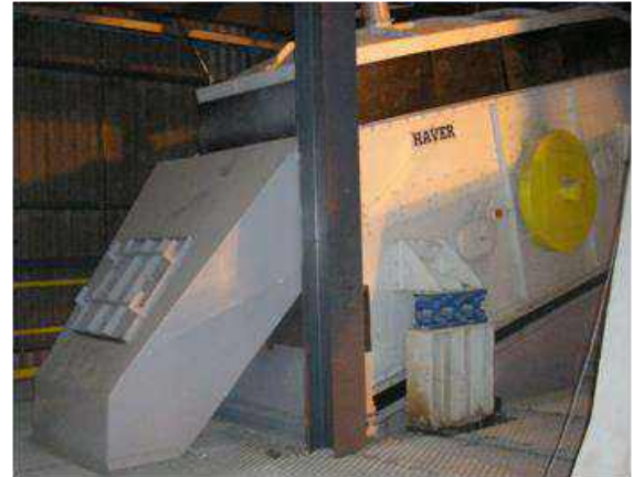
Figura 2.2.3.3-10: Vista do detalhe de uma das peneiras Haver, totalmente enclausurada
