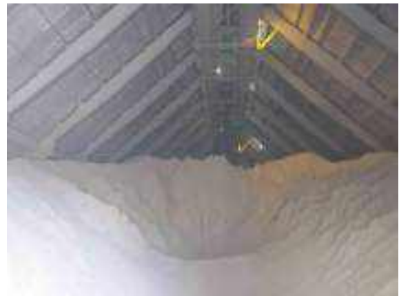
Figura 2.2.3.2-4: Vista interna do armazém de rocha
