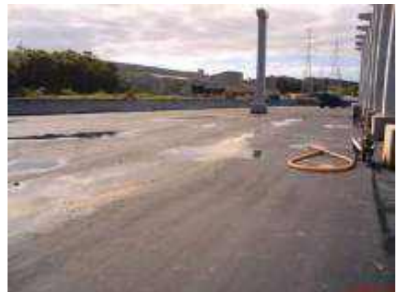
Figura 2.2.4.2-10: Pátio de estocagem de enxofre pronto, impermeabilizado e asfaltado (abr/2008).
