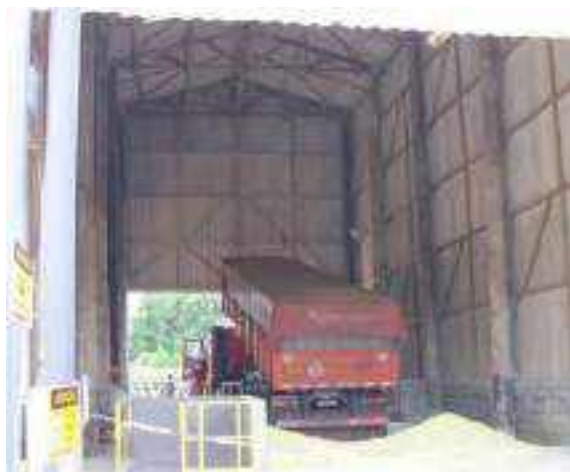
Figura 2.2.3.1-1: Vista da área de descarregamento de enxofre, antes da instalação de cortinas protetoras.
