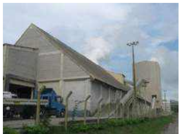
Figura 2.2: Armazém de rocha e suas correias transportadoras externas.
