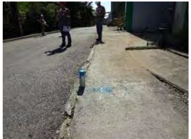
Figura 25 - Vista das construções junto ao limite da APP
