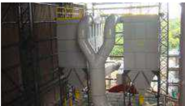
Figura 2.2.5.2-38: Vista da época da instalação dos Filtros de Mangas do Resfriador de Gases
