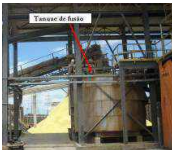
Figura 2.2.3.1-4: Tanque de fusão
