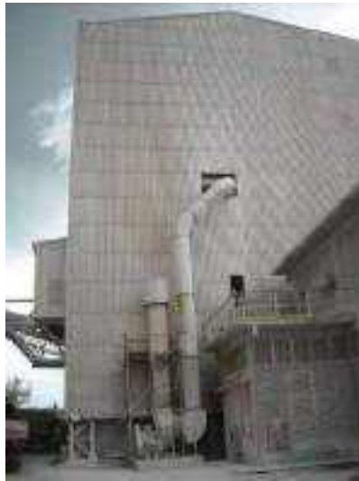
Figura 2.22: Vista geral da chaminé do sistema de despoeiramento da granulação
