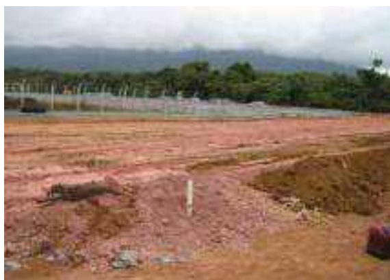
Figura 2.2.4.1-9: Obras de preparação do terreno para a implantação das unidades industriais (nov/2007).
