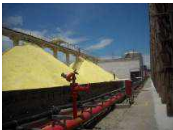
Figura 2.2.3.1-3: Vista do pátio de armazenagem de enxofre.
