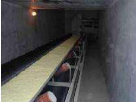
Figura 2.2.5.2-5: Trecho de correia transportadora de enxofre em túnel de concreto evitando emissões.
