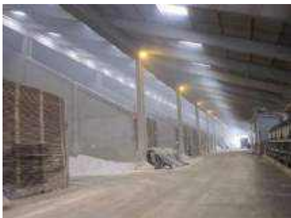
Figura 2.2.3.4-5: Vista geral dos Boxes de matérias primas das Misturas 3 e 4
