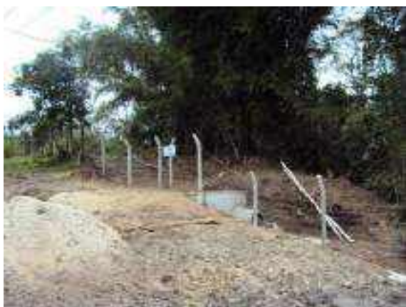
Figura 2.5.4-11: Melhorias na saída da manilha final de efluentes
