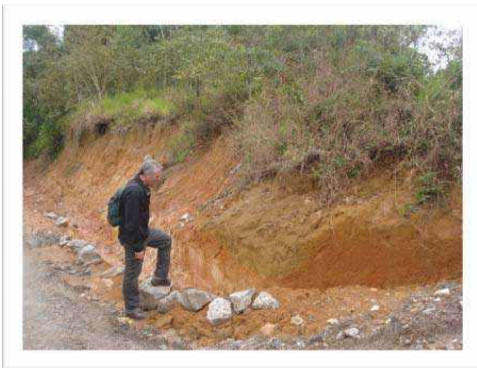
Figura 15 Vistoria no entorno imediato do empreendimento
